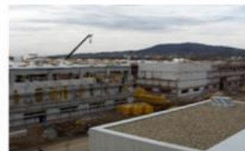
Logisztika és gépszerelő üzem bővítése
